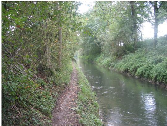
Abbildung 19: Ehbach – gleichförmiges Gerinne mit trapezförmigem Profil.
